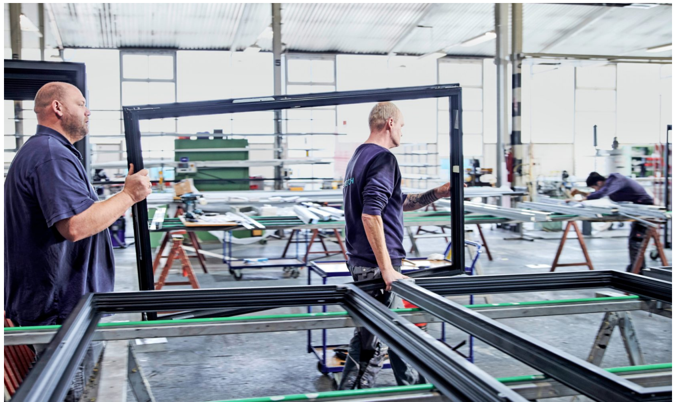
Aus Alt wird Neu: Für den Bau der Fassade in Bremen wird ein Großteil alter Baumaterialien genutzt.
